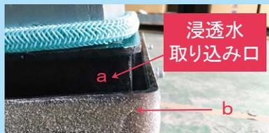
隙間から流入した水は、浸透水取り込み口からサンドフを通過して、半円の切欠き部(赤丸部)より排水柵内部へ導きます。
